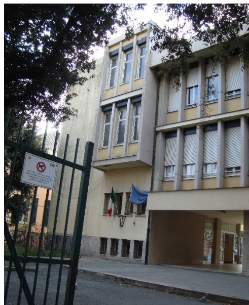
Figura 1.1 - Vista della facciata Nord
