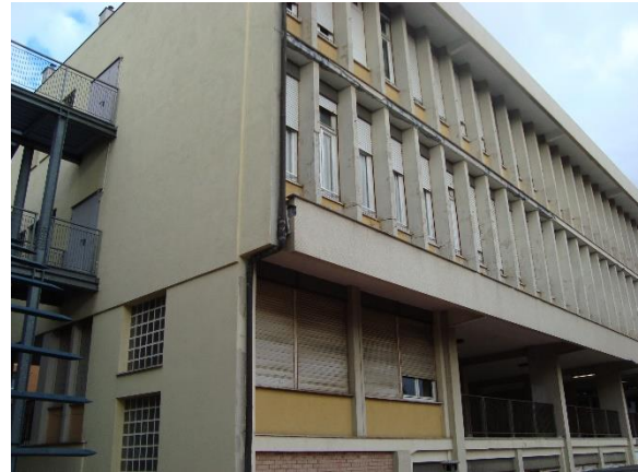
Figura 4.1 - Particolare facciata ovest fabbricato
