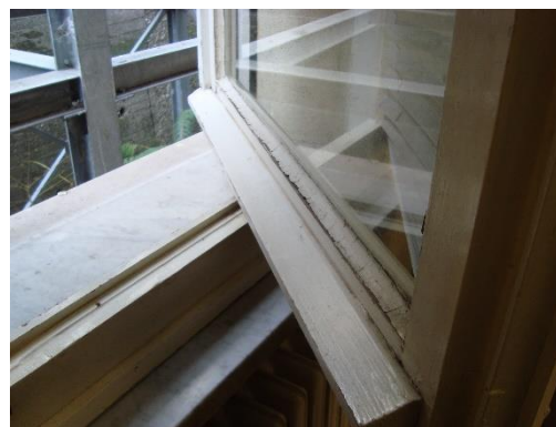
Figura 8.1 – Particolare dei serramenti esistenti
