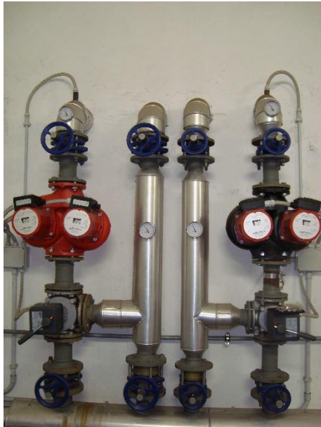
Figura 4.8 - Particolare collettori di mandata e valvole a tre vie
